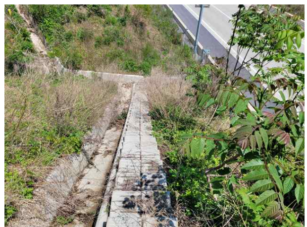
상부 사면 점검시설
